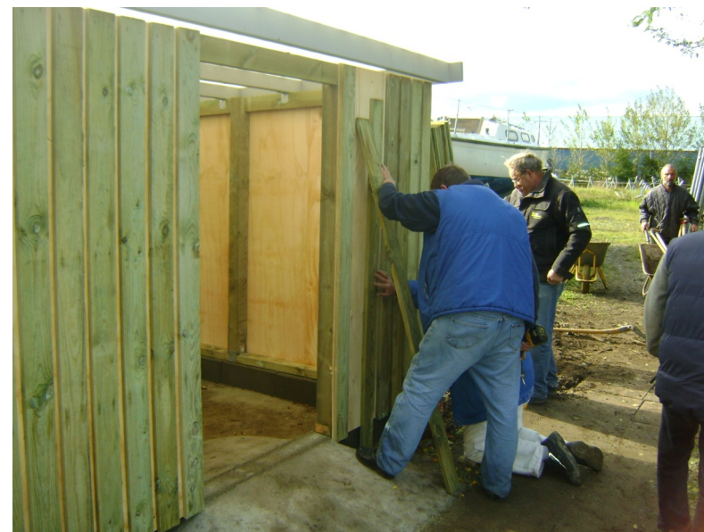
Der arbejdes ihærdigt på vores nye miljøhus.
